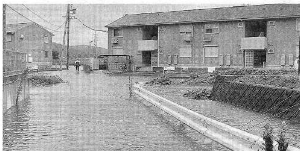
大雨の影響で冠水した道＝伊賀市三田で
