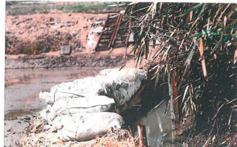
③田んぼのあぜ道が崩れると土嚢で補修
