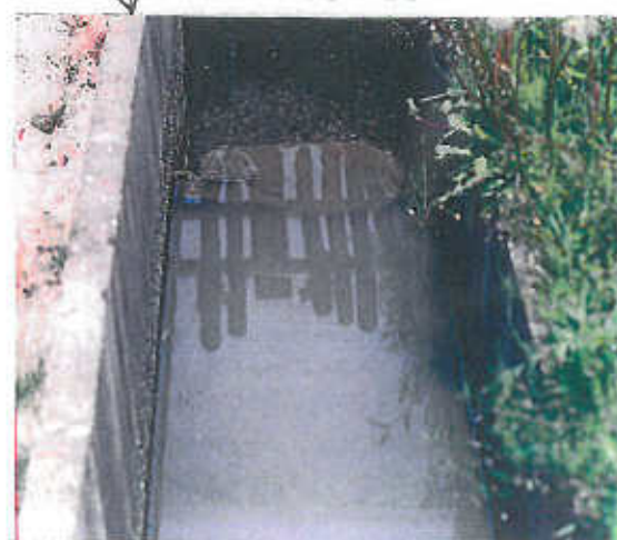
③新しく設置された土のう②
