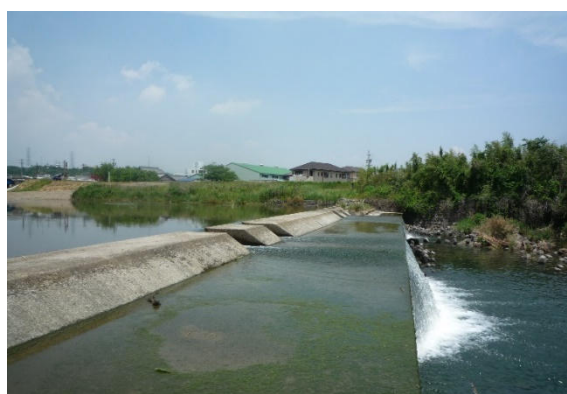
同じ場所に、コンクリートの堰となつて残る横井井堰
