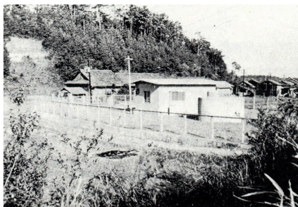
内部簡易水道水源施設、当時の写真。
