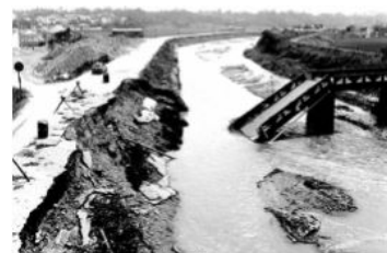
内部川 北小松橋流出状況 (写真は四日市市史より)
