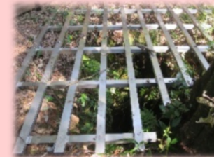
安全柵で覆われた古井戸
