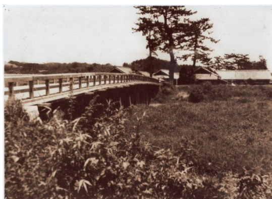
昭和 17 年 (1942) 完成の東海道内部橋 (木橋) 南詰より小古曽方面を望む。
