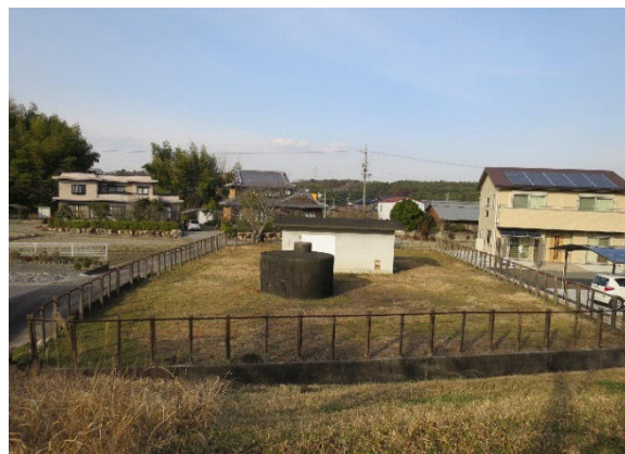
北小松地内に今も残る簡易水道の水源設備。 約 50m 西には内部水源系第 5 号ポンプ所がある。
