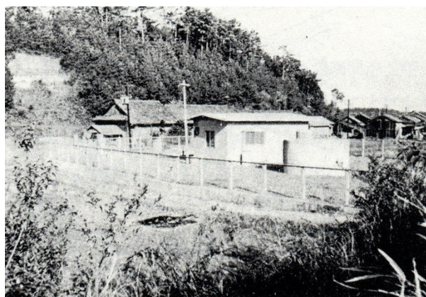
内部簡易水道水源施設、当時の写真。
